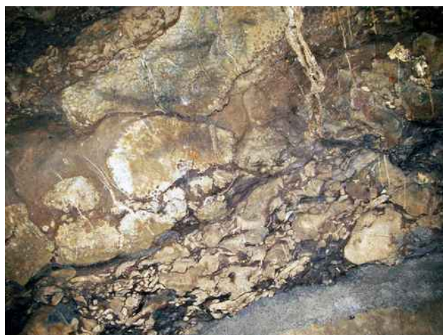
Figure 15. Altération de la partie micritique du calcaire. Les gros fossiles (coraux, stromatopores, en formes de boules blanches) sont épargnés, à l'encontre du ciment calcaire entre eux. La bande grise en bas à droite est du ciment recouvrant un câble électrique.
