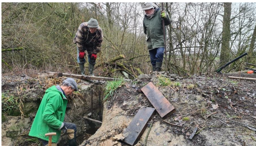
Travaux d'implantation d'un moine sur le chenal de la mare du Cobri (photo Véronique LEMERCIER, 6 février 2021).
