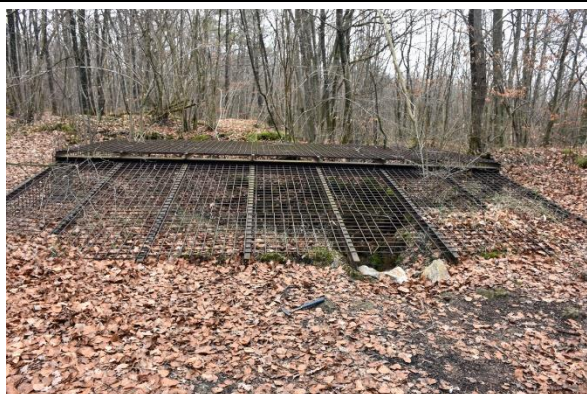
Entrée grillagée du puits n°8 dans le versant de la colline, maintenant boisée
