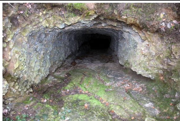
Vue plongeante du puits n°8 de 70 m de profondeur
