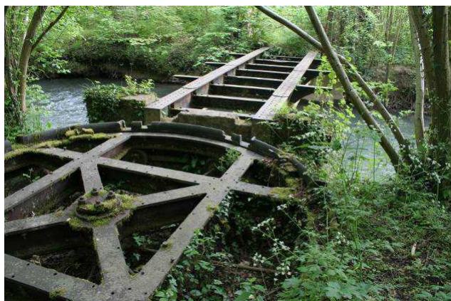
Ici, une plaque tournante et un pont métallique donnaient accès à l'ancien moulin Sagot-Avot, devenu Dambricourt. (MG)
